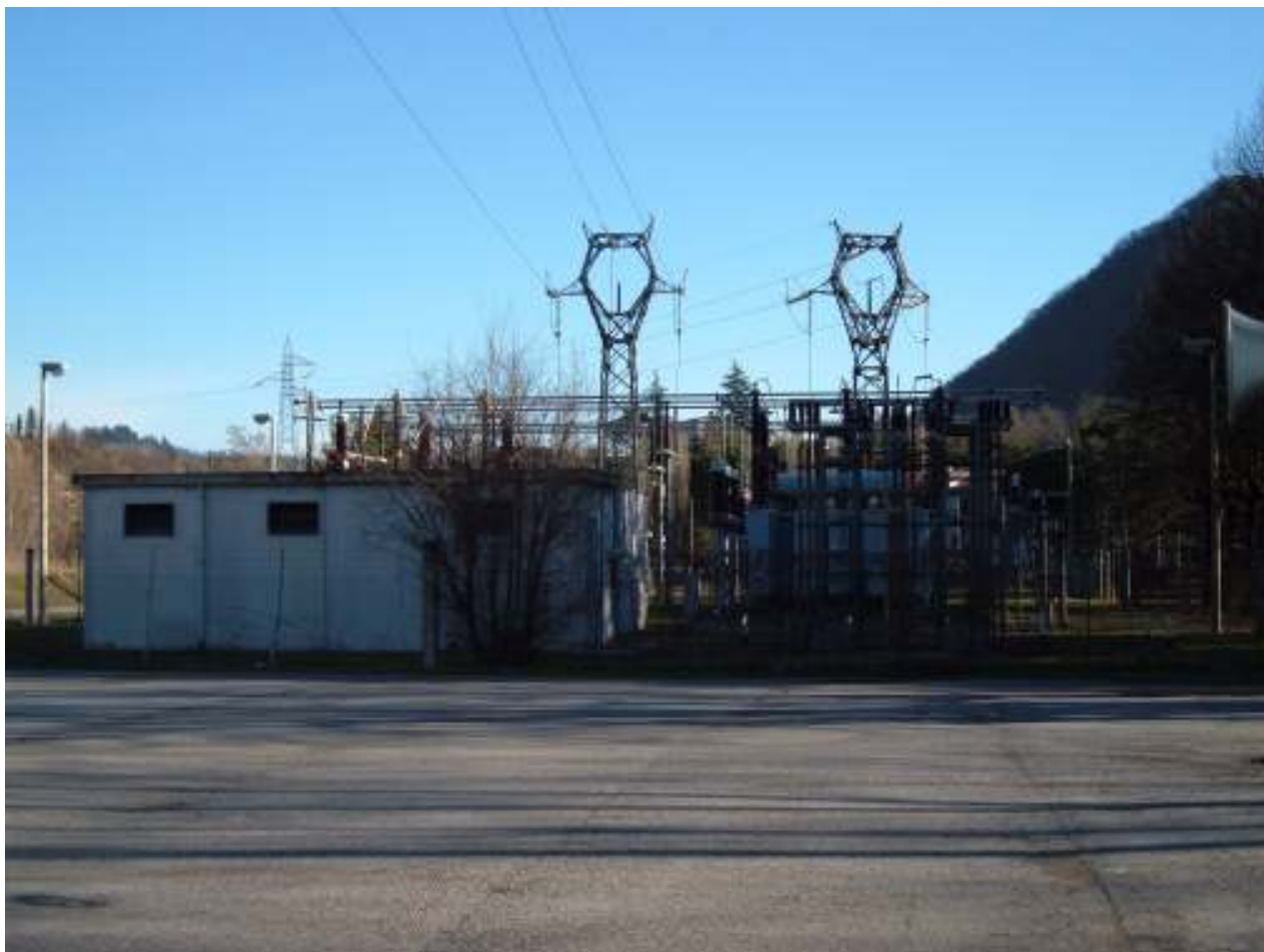
Figura 2: Stazione Elettrica annessa al complesso dell'Ex-Cartiera.
