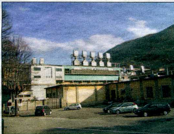
LA CARTIERA DI LAMA DI RENO CHE POTREBBE ESSERE RICONVERTITA IN UN IMPIANTO A TURBOGAS
