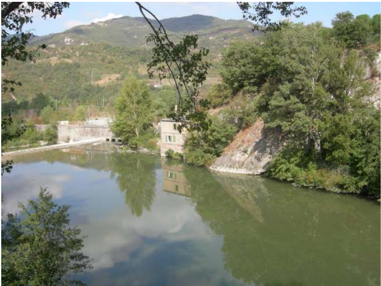
Fig. 1 - Lago di calma a monte della traversa di Panico, con le due opere di presa.
