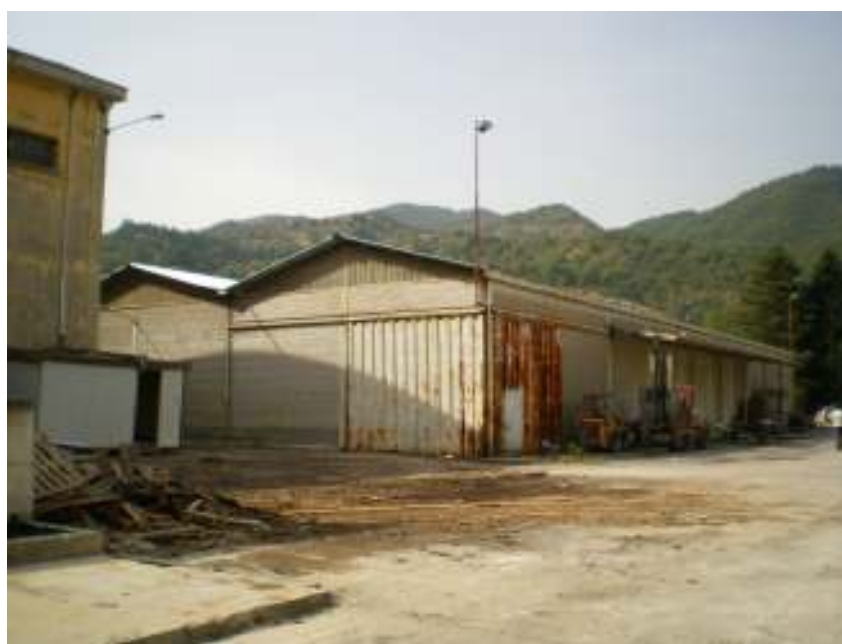
Figg. 1-2 - Area di intervento allo stato attuale
